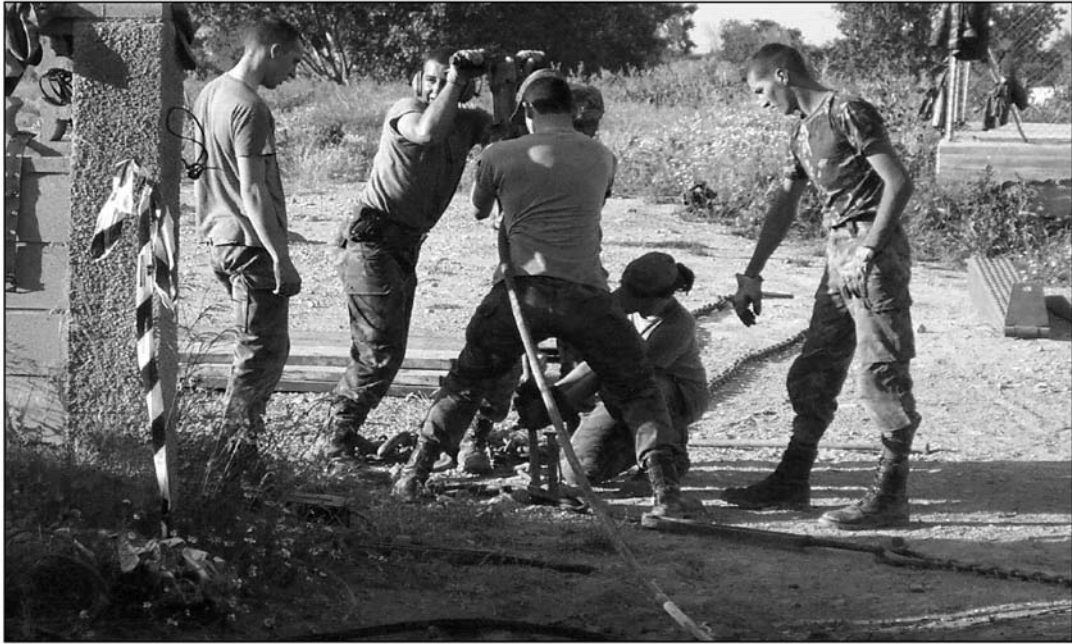
Foto 9. 12 MAY 03. Equipo de Anclado. Colocación de las cadenas de anclaje.
