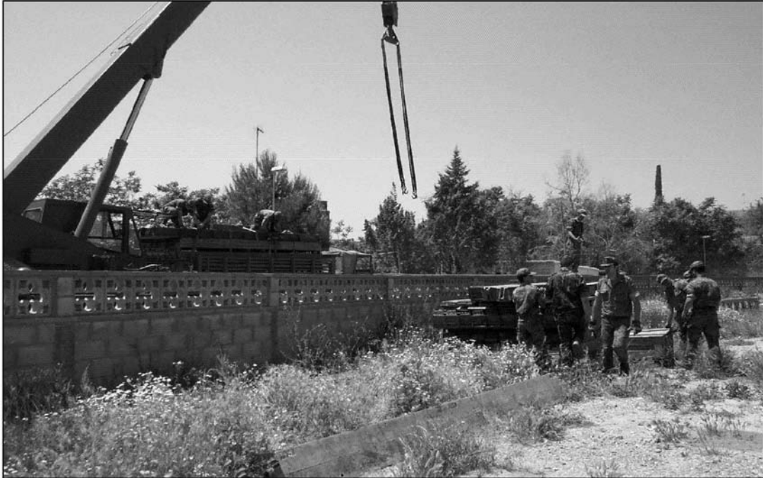
Foto 5. 12 MAY 03. Descarga de materiales. Establecimiento del Parque de Puentes.
