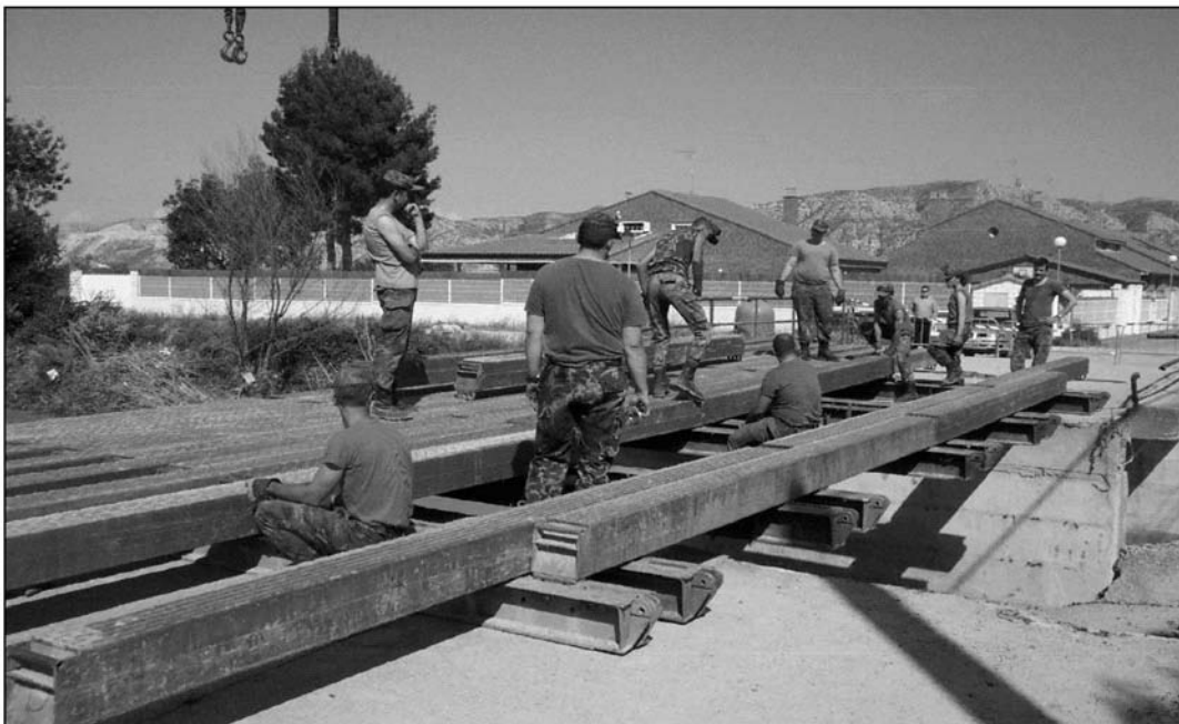
Foto 8. 12 MAY 03. Sección de Montaje. Se completa la estructura con vigas.
