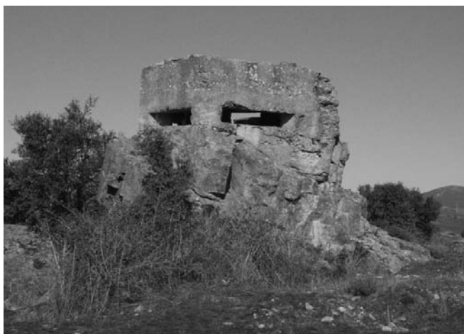
N.7 Fortín de Primera Línea en el frente de Somosierra.
