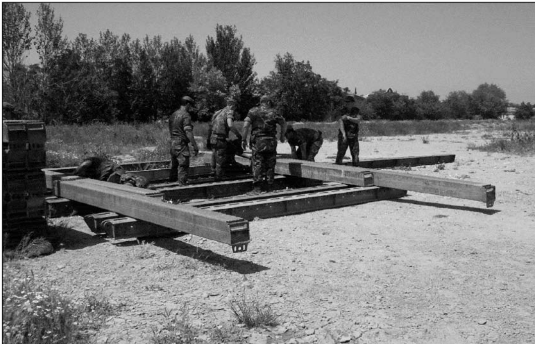
Foto 6. 12 MAY 03. 1º Pelotón de Montaje. Montaje de la estructura en vigas maestras.
