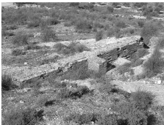
N.3 Fortificación de los primeros días, parapeto construido con ladrillos. Fotografías del autor.
