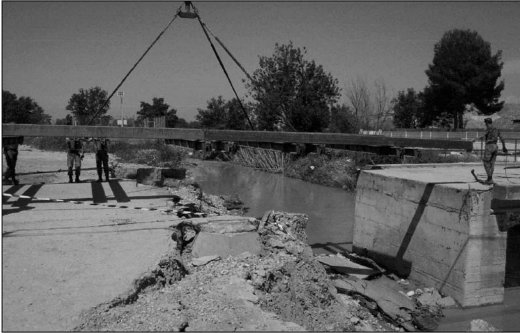
Foto 7. 12 MAY 03. 2º Pelotón de Montaje. Colocación de la estructura en vigas maestras.
