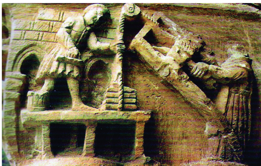
Trabajos artesanos en construcción de templos. Capitel de Santa María de la Nave. Museo Arqueológico Nacional. Madrid
