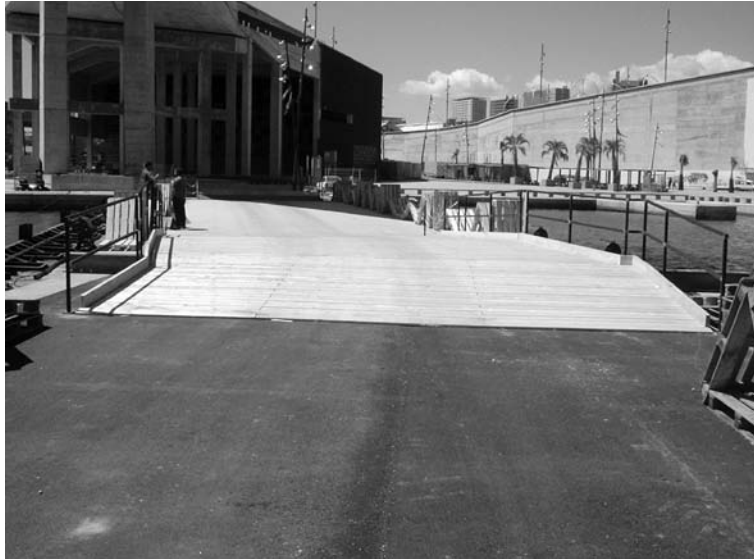
Foto 19. FÓRUM-04. Detalle de la calzada de madera.
