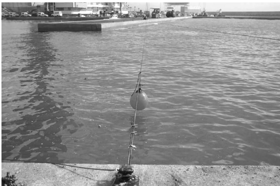
Foto 5. 30 MAR 04. FÓRUM-04. Cable fiador tendido.
