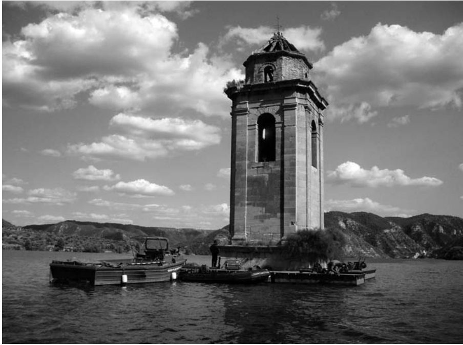
Detalle de la colocación de los primeros pontones y de los tornos.
