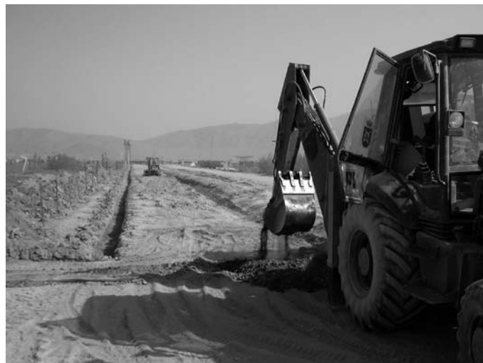
Foto 7. Desmonte zona paso tuberías.
