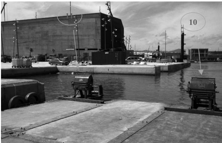
Foto 10. 01 ABR 04. FÓRUM-04. Detalle de los puntos de anclaje 10 y 11.
