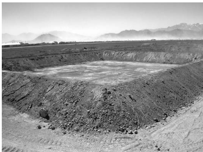
Foto 3. Balsa n.º 1 con merlón de protección.
