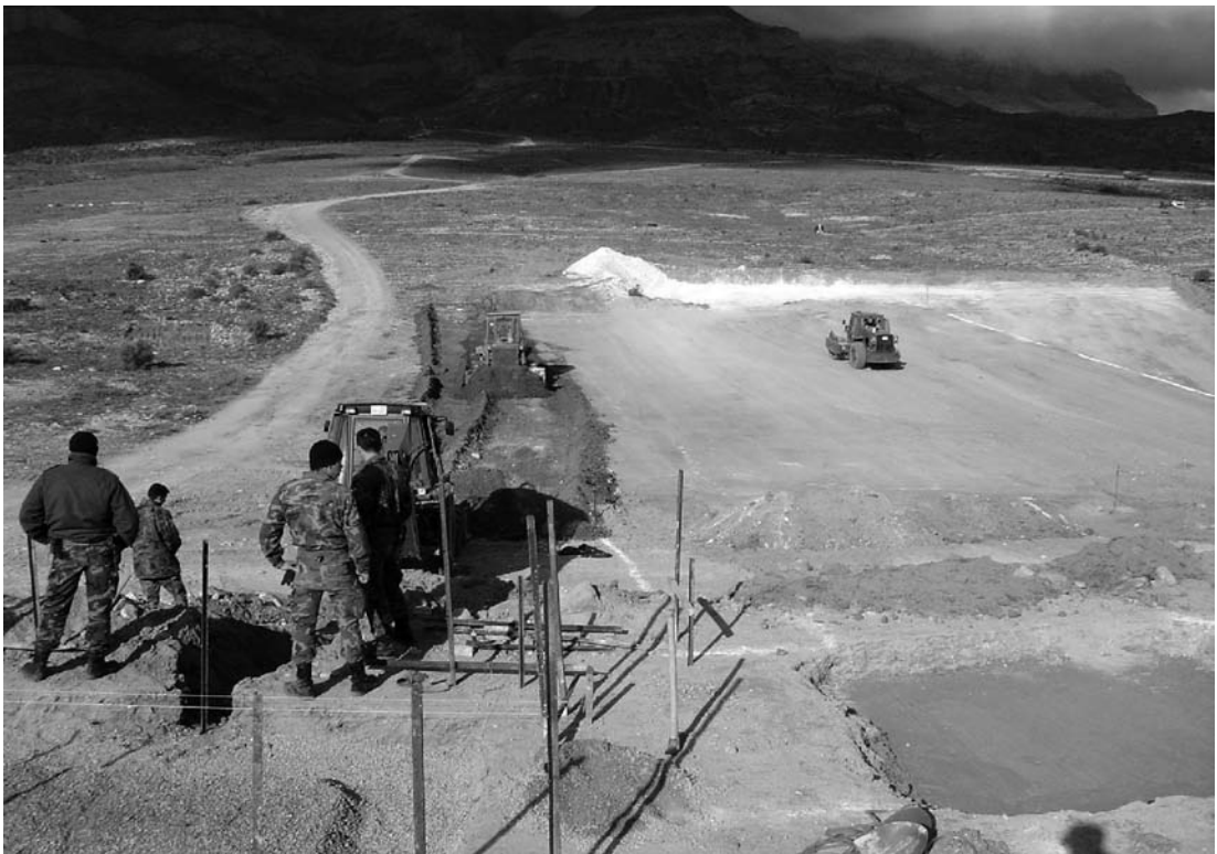
Inicio de la obra.
