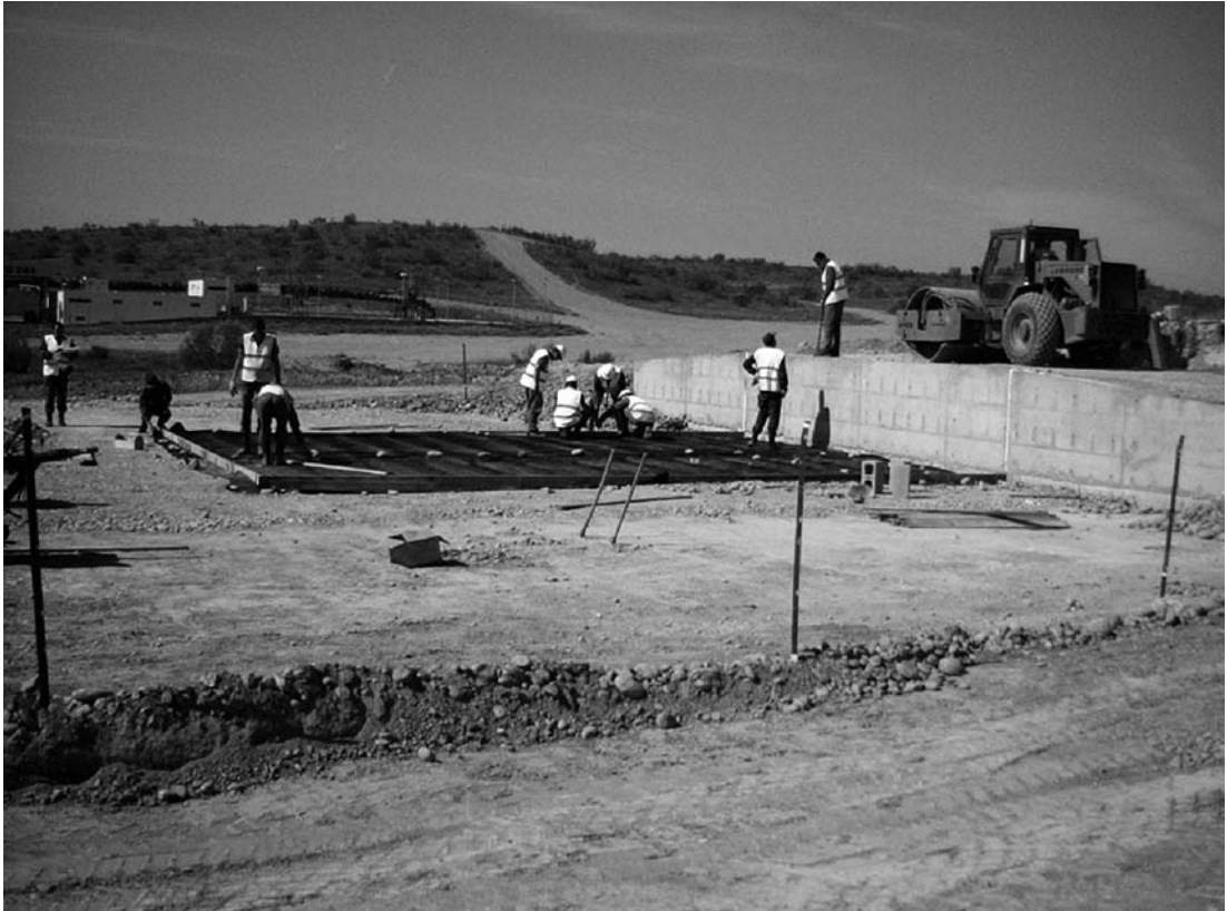
Construcción de un «Bunker» en C.T. Boyero I.
