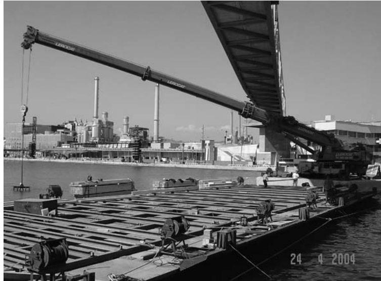
Foto 16. 24 ABR 04. FÓRUM-04. Colocación de cuerpos muertos. Detalle de la estructura metálica construida por la empresa NUSSLY.
