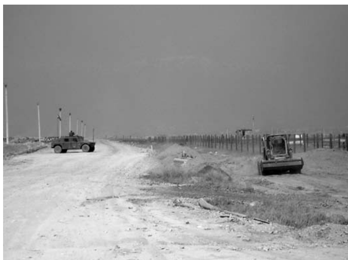
Foto 4. Protección en los trabajos.
