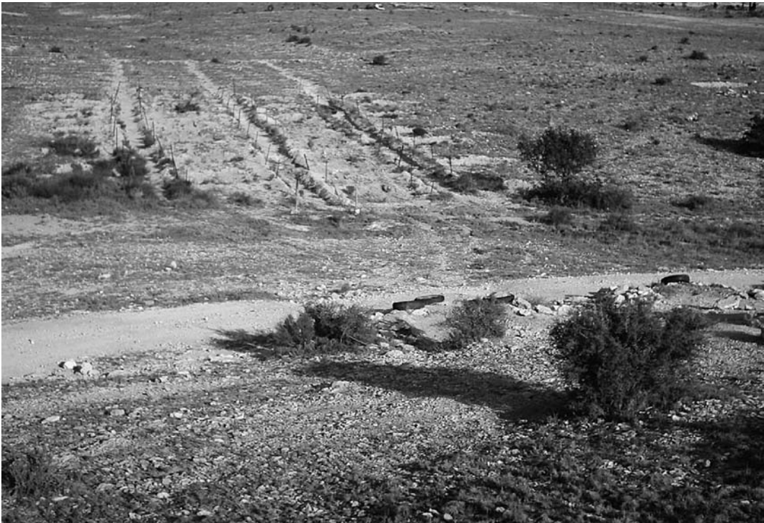
Zona previa a inicio de la obra
