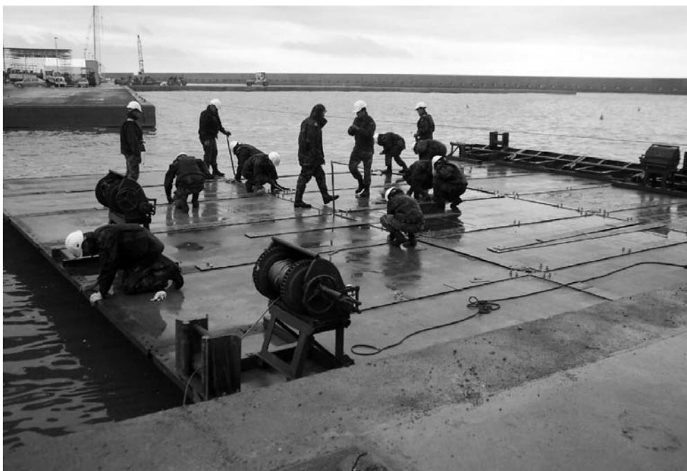
Foto 6. 30 MAR 05. FÓRUM-04. Primer elemento MCL-80 case «A» sobre el agua. Colocación de las Placas de Seguridad
