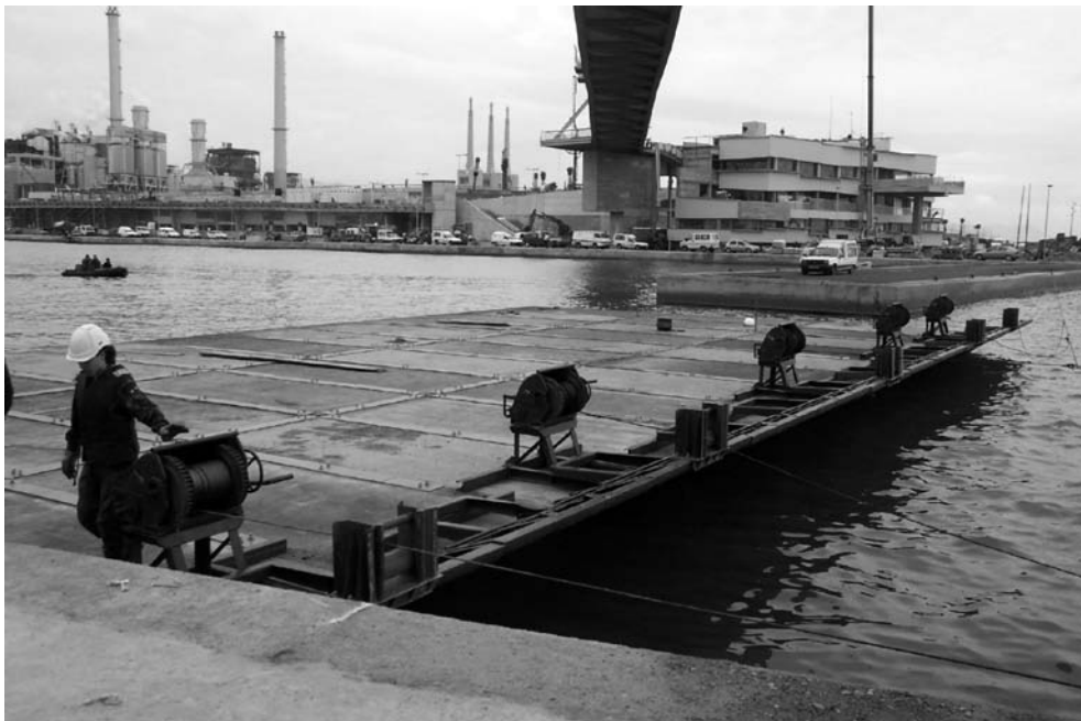
Foto 8. 31 MAR 04. FÓRUM-04. Dos (2) elementos de puente MCL-80 Clase «A» y 5/6 del último. Se aprecian los tornos 1, 2, 3, 4 y 5 unidos al cable fiador. Al fondo, ZODIAC de Seguridad.
