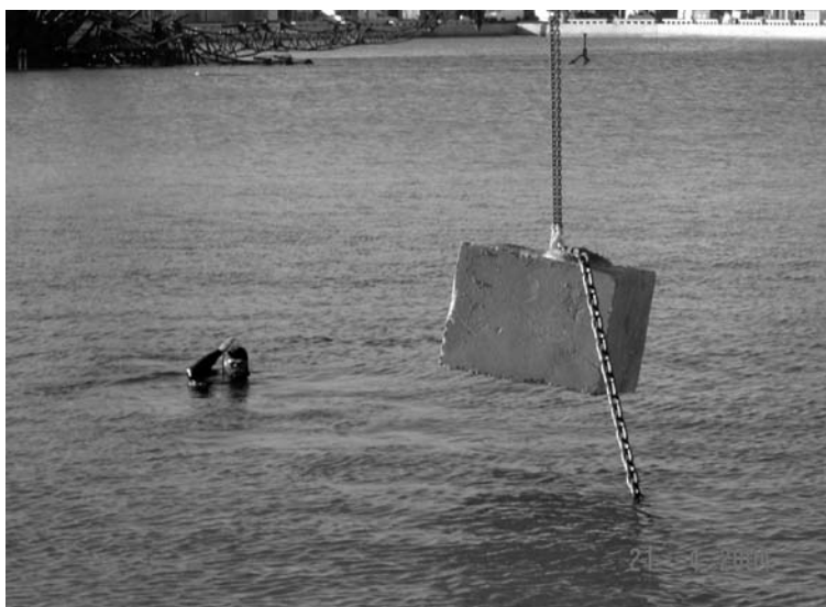
Foto 15. 21 ABR 04. FÓRUM-04. Colocación de cuerpos muertos.
