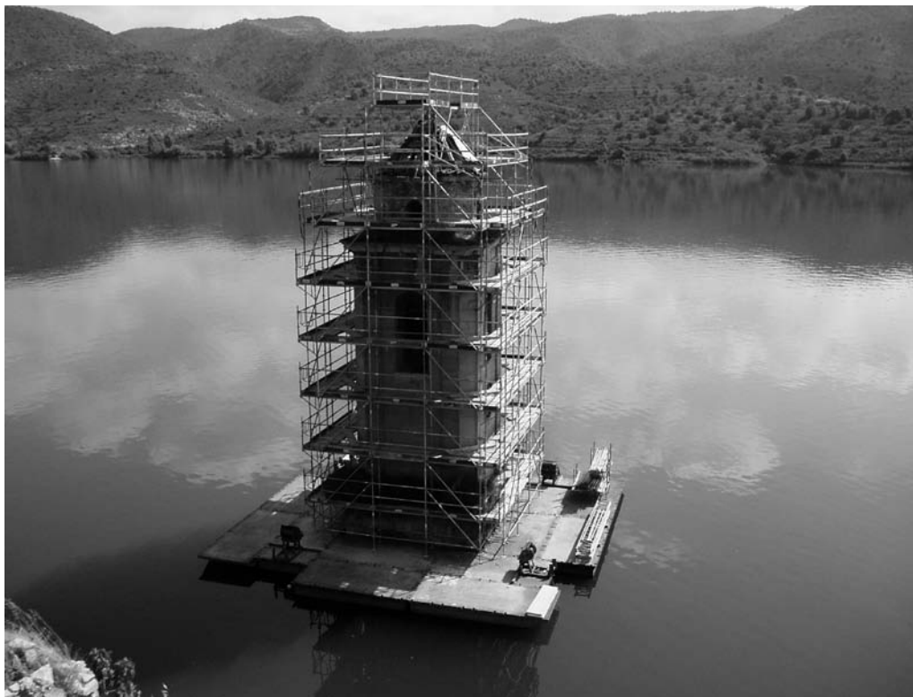
Montaje completo del andamiaje metálico.
