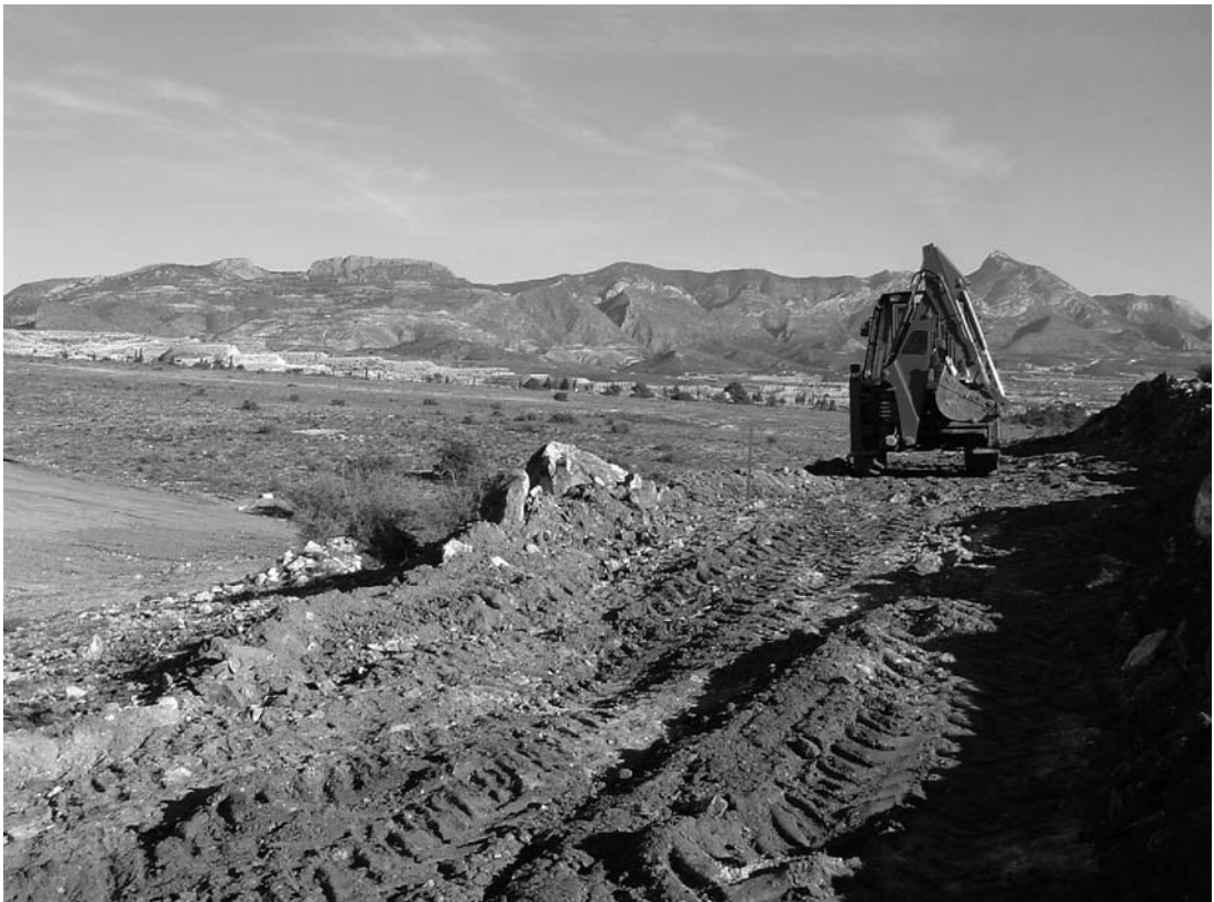
Inicio de la obra.
