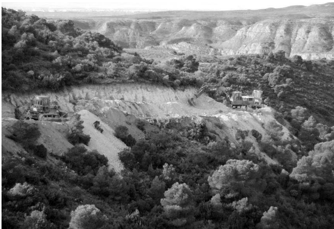
Apertura de nueva traza en camino.
