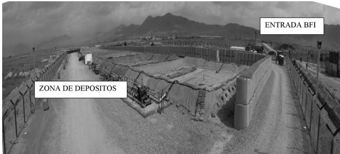
Foto 8. Vista general del BFI.
