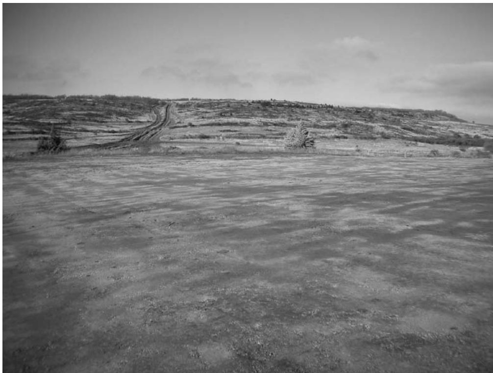
Aspecto general de la explanada terminada
