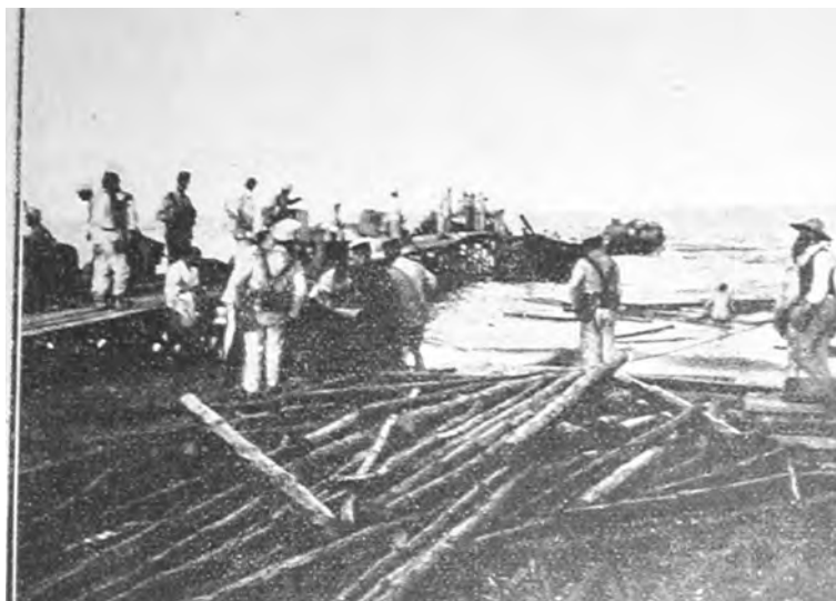
Fotografía aparecida en El Mundo Militar de la construcción de un desembarcadero en La Restinga
