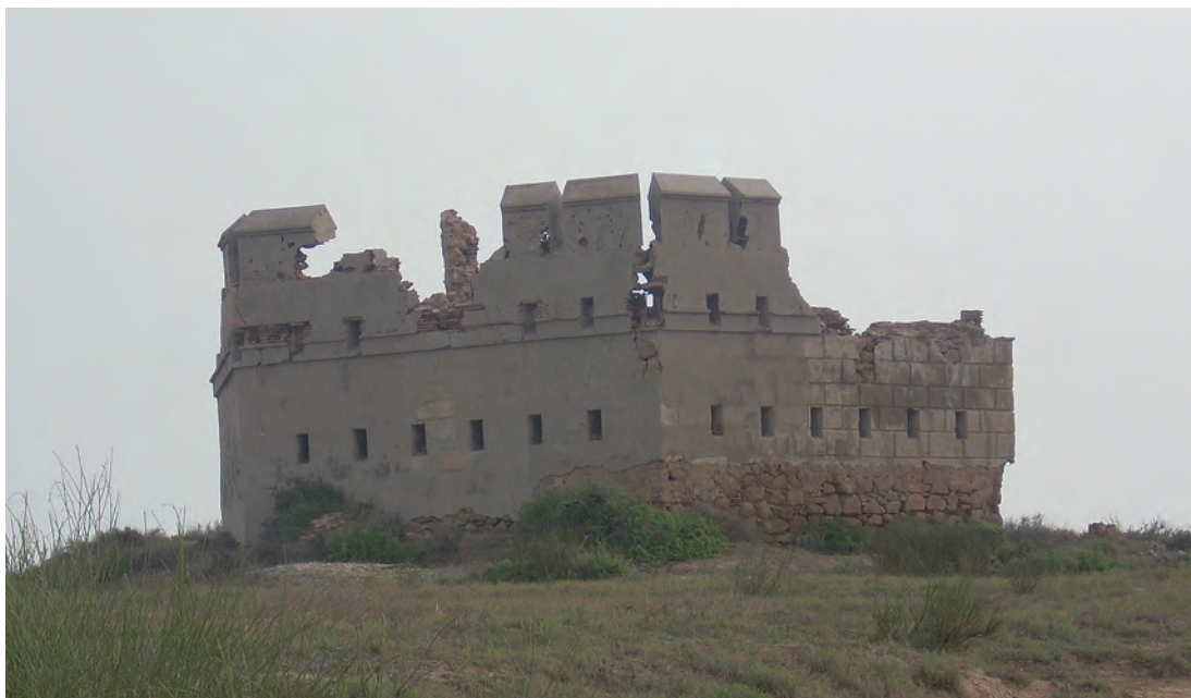
Restos del fortín de La Restinga en la actualidad. Queda el foso escavado alrededor y parte de su primitiva estructura tras cien años edificado. Foto de la autora.
