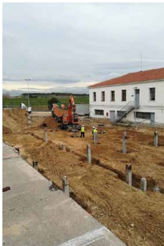
Construcción del BIP UAD-RAS II-31 (Autor: Página web de la DIIN)
