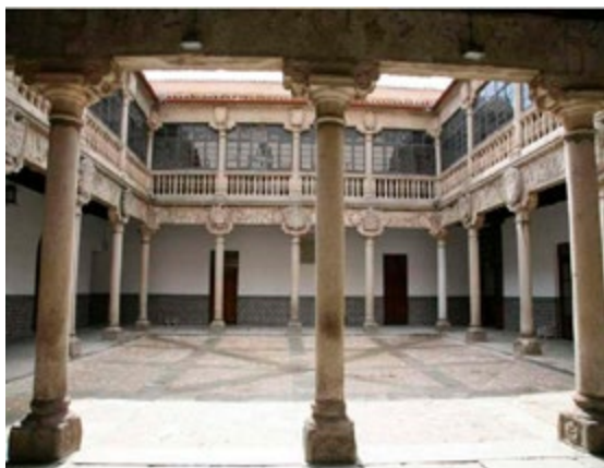
Vista del patio de armas del Placio de Polentinos
