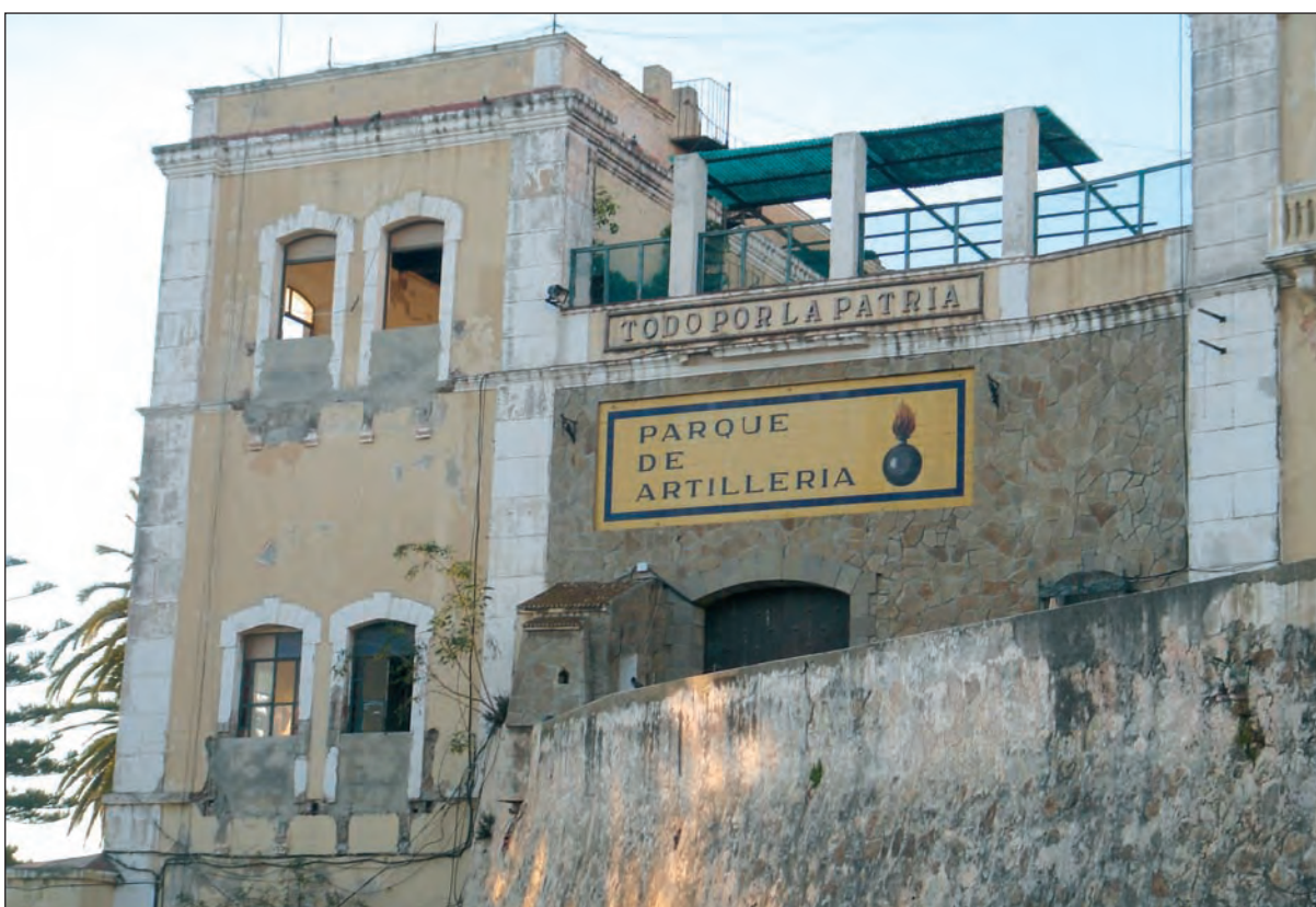
Parque de Artillería, entrada principal
