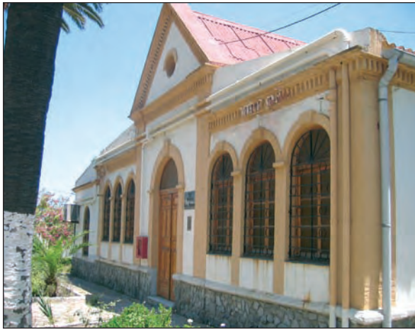
Entrada principal al edificio del Bar de Mandos
