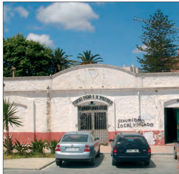
Fachada de la Panadería Militar
