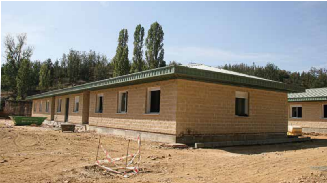
Multiusos del BIEM V en construcción. Fotografía: España. Ministerio de Defensa. Unidad Militar de Emergencias. Oficina de Comunicación Pública
