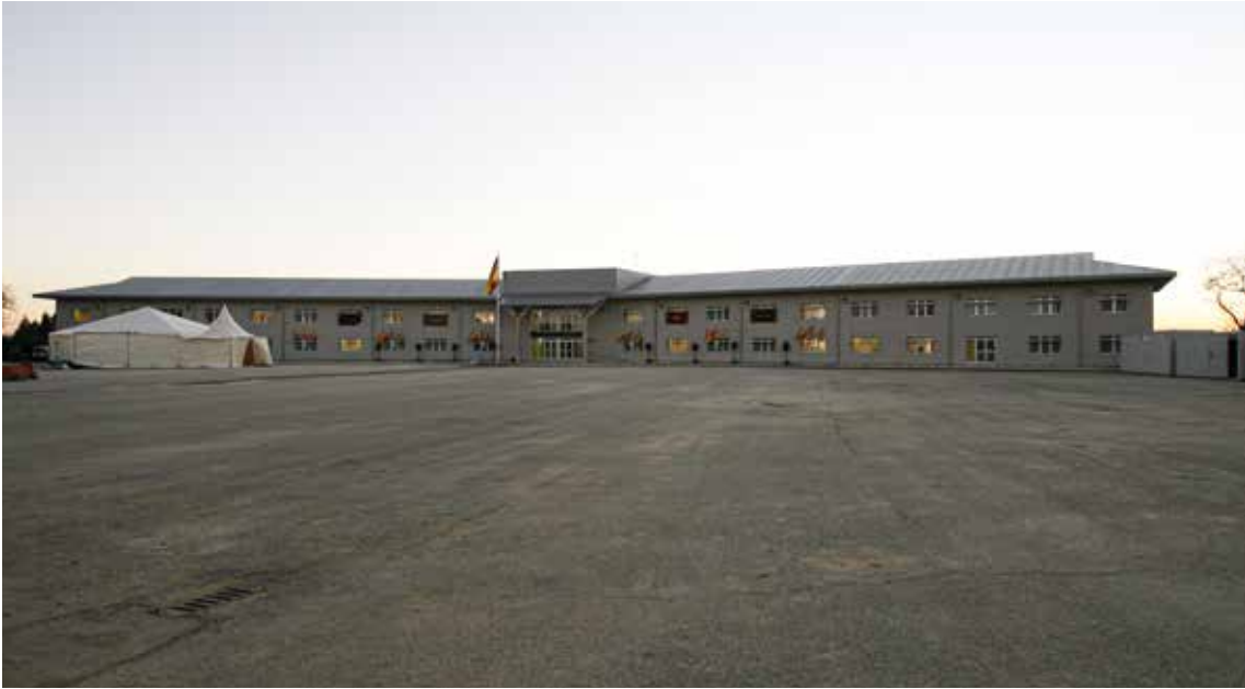
Edificio de mando del CGUME en Torrejón de Ardoz. Fotografía: España. Ministerio de Defensa. Unidad Militar de Emergencias. Oficina de Comunicación Pública
