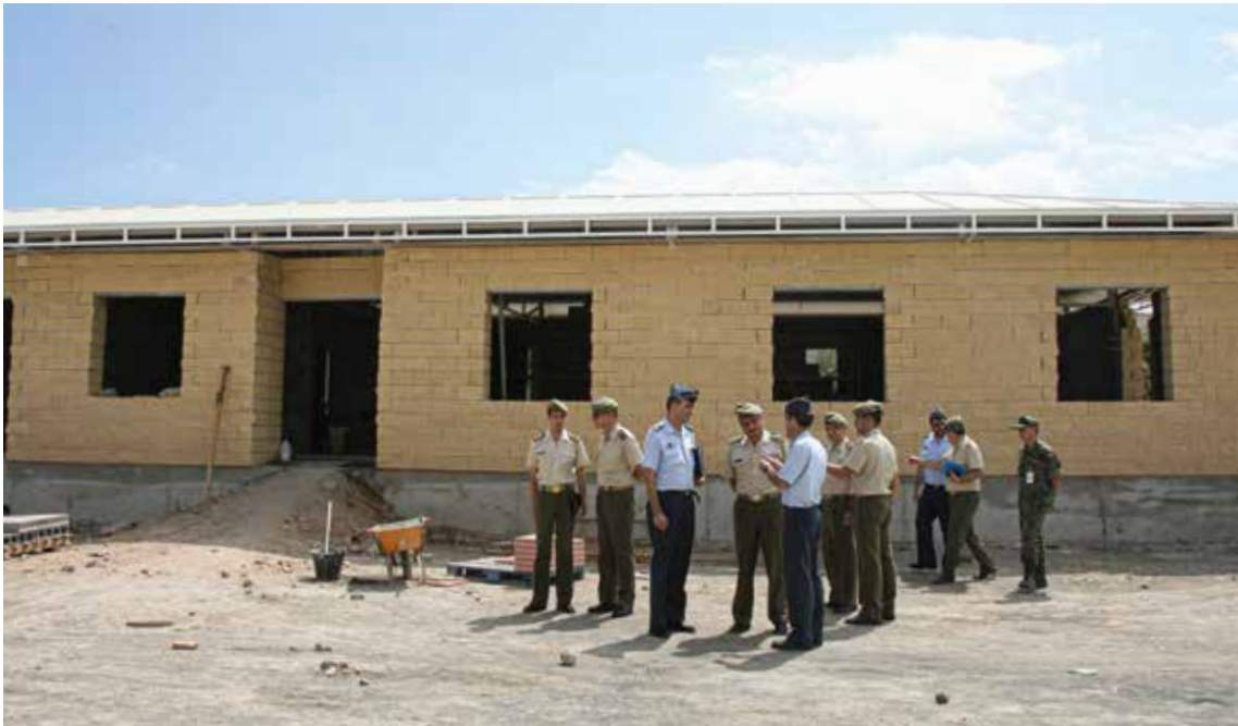
Multisusos de la UIEN de Gando. Fotografía: España. Ministerio de Defensa. Unidad Militar de Emergencias. Oficina de Comunicación Pública
