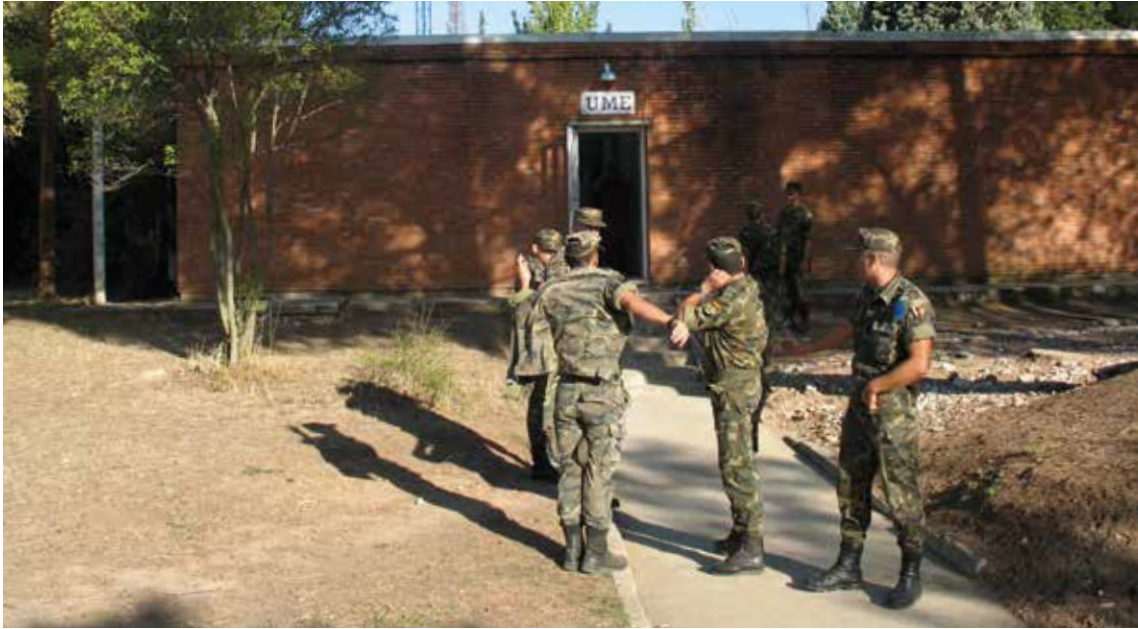
Edificio del BIEM I, RAEM y UCG (Torrejón de Ardoz). Fotografía: España. Ministerio de Defensa. Unidad Militar de Emergencias. Oficina de Comunicación Pública
