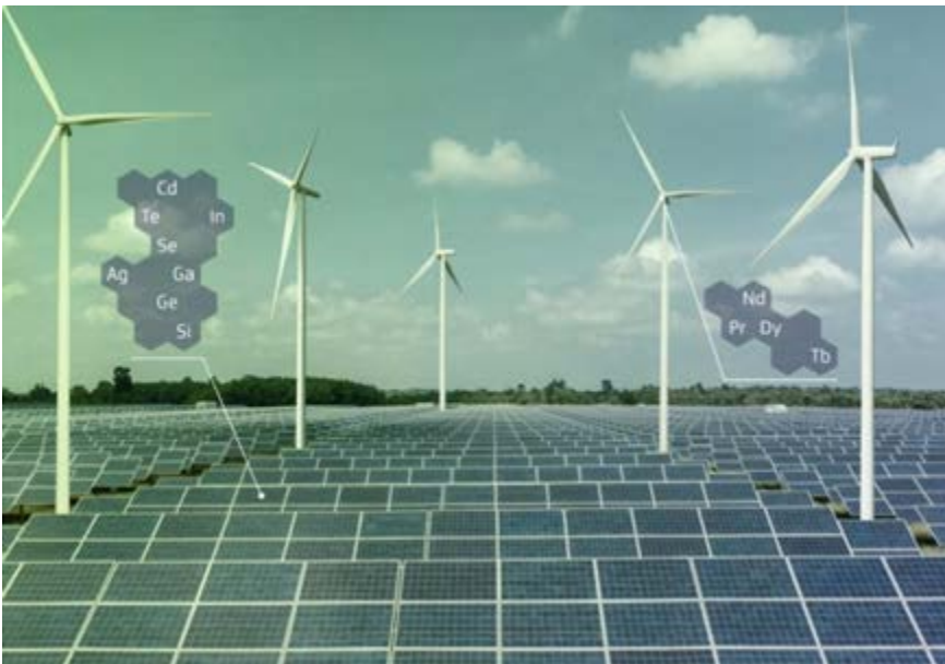
Foto 7. Parque mixto con las tecnologías más implantadas actualmente: eólica y fotovoltaica.
