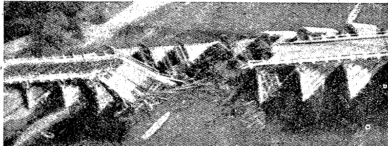
La precisión del ataque de los «Stukas» se refleja bien en este pequeño puente, destruido, por impacto directo, con una sola bomba.
