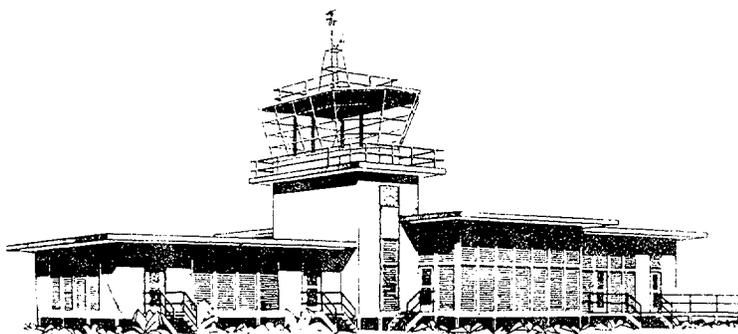
*Edificio terminal prefabricado (tipo A), el más sencillo de todos. Se compone de un cuarto de aparatos y de una sala de espera para viajeros, con los servicios anejos, para un número reducido de pasajeros. En la fotografía pueden apreciarse los tres tipos, para zonas tropical, templada y polar. Además se facilitan también dos grupos con terrado, para zonas templada y polar. La distribución de las habitaciones en los cinco pisos es idéntica.*
