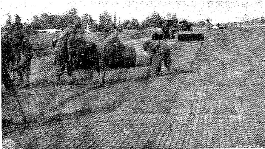
*Se utiliza la tela metálica de acero para revestir un campo de aviación provisional en Francia.*
