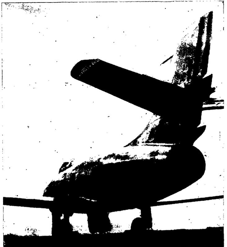
Una vista del "Ouragan", primer avión de reacción francés, que ha efectuado sus pruebas de vuelo con gran éxito. Este caza, cuya construcción se inició en abril de 1948, estaba terminado en enero último, y va provisto de un turborreactor "Nene", construido con licencia por la Hispano Suiza, con un empuje de 2.250 kilogramos. Se espera que alcance una velocidad de 1.000 kilómetros-hora.
