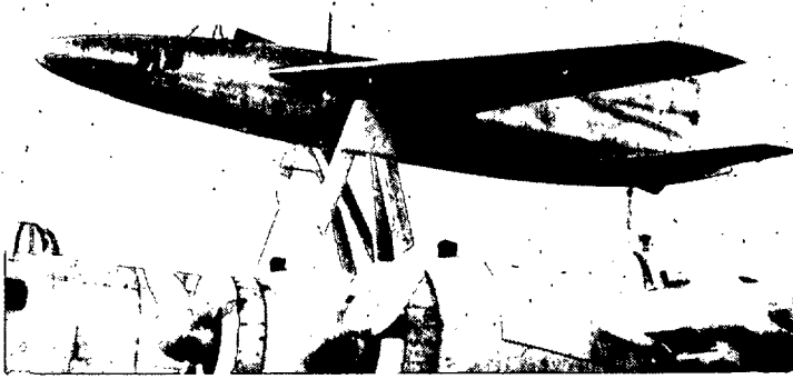
El SOM-1 "Leduc" es un avión experimental, dotado de un motor Walter, modificado por la S. C. E. P. R. Despega desde un "Languedoc" y está proyectado para alcanzar un número de Mach de 0,9. Se le emplea para determinar la polar del ala en vuelo y estudiar la sustentación y la resistencia al avance.
