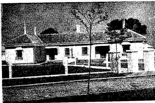
Casas de Suboficiales en Granada.
