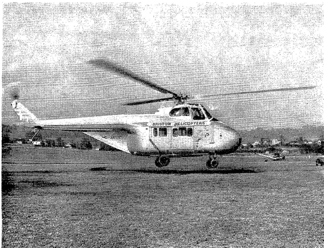
*La Bristol Helicopters, lo mismo que la RAF, está instalando en sus helicópteros Westland Whirlwind, con motor de pistón, motores de turbina Gnome, que han mejorado apreciablemente sus características.*
