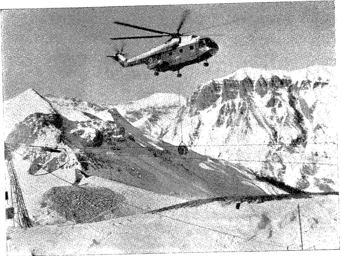
*Un helicóptero francés Super-Frelon 03, transporta desde Niza al teleski de Auron, a 2.500 metros de altura, un cable de un peso de dos toneladas.*
