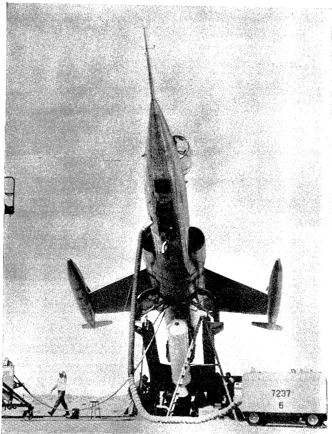
Un F - 104 "Starfighter" en su plataforma de lanzamiento desde la que despegará impulsado por el cohete Rocketdyne que lleva acoplado.
