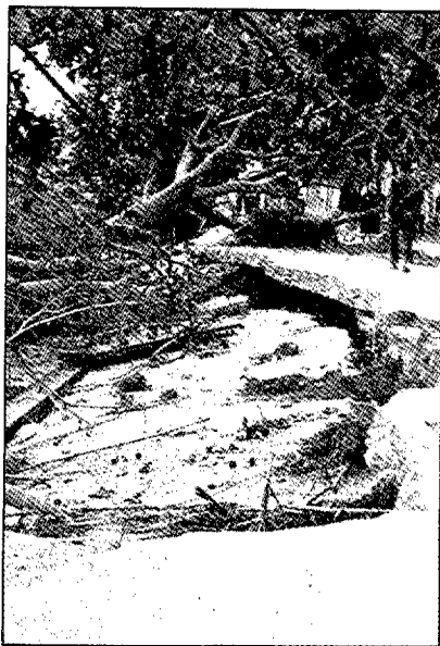
Este socavón produjo la cascada que arrastró a Bautista
