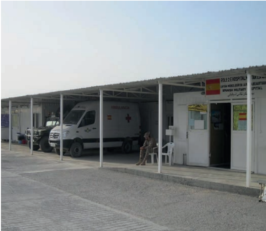
Entrada del hospital Role 2 en la Base Aérea de Herat.
