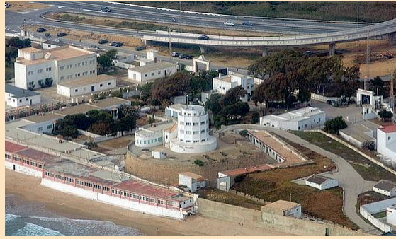
Centro de Ensayos de Torregorda Cádiz.
