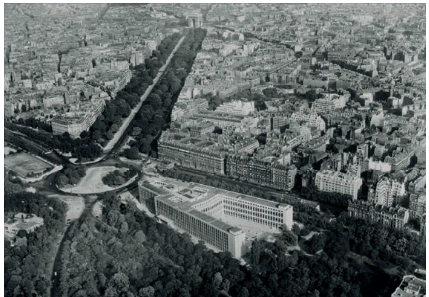
El edificio construido en París para ser el CG de la OTAN tuvo una corta vida como sede de la Alianza
