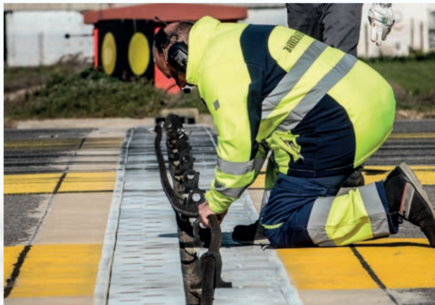
Miembros de la sección de la barrera de frenado colocando el cable para la prueba
