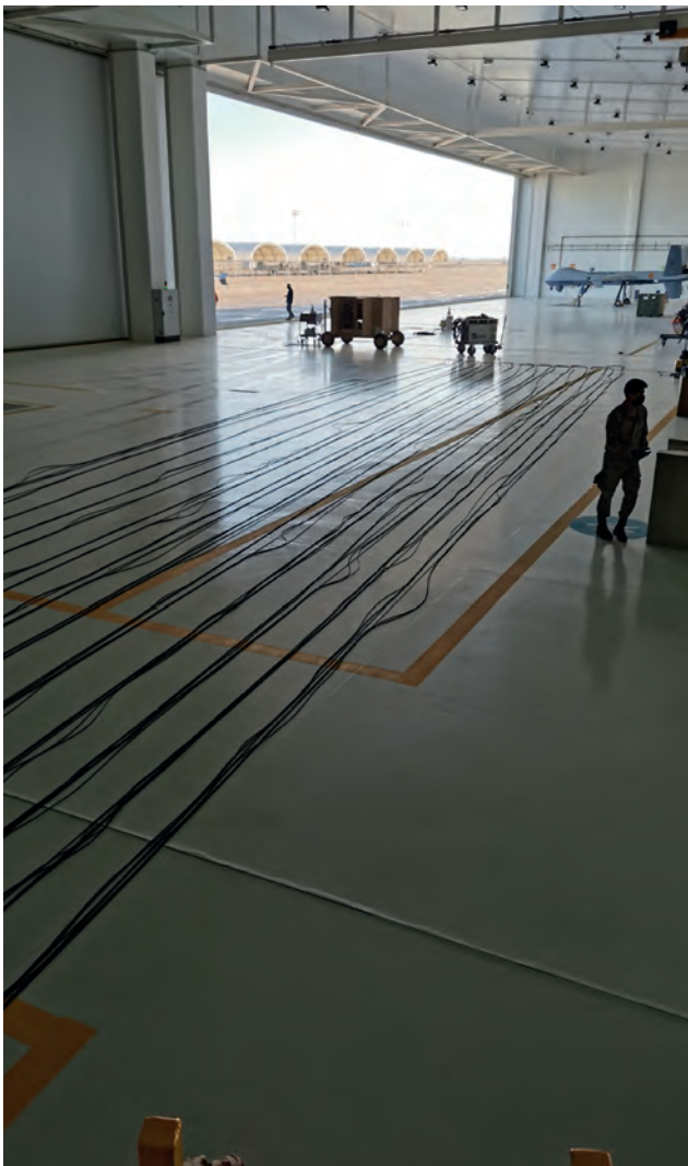
Apoyo en tendido de fibra óptica para la operación de los UAV MQ-9 Predator B en la base aérea Talavera en marzo de 2022
