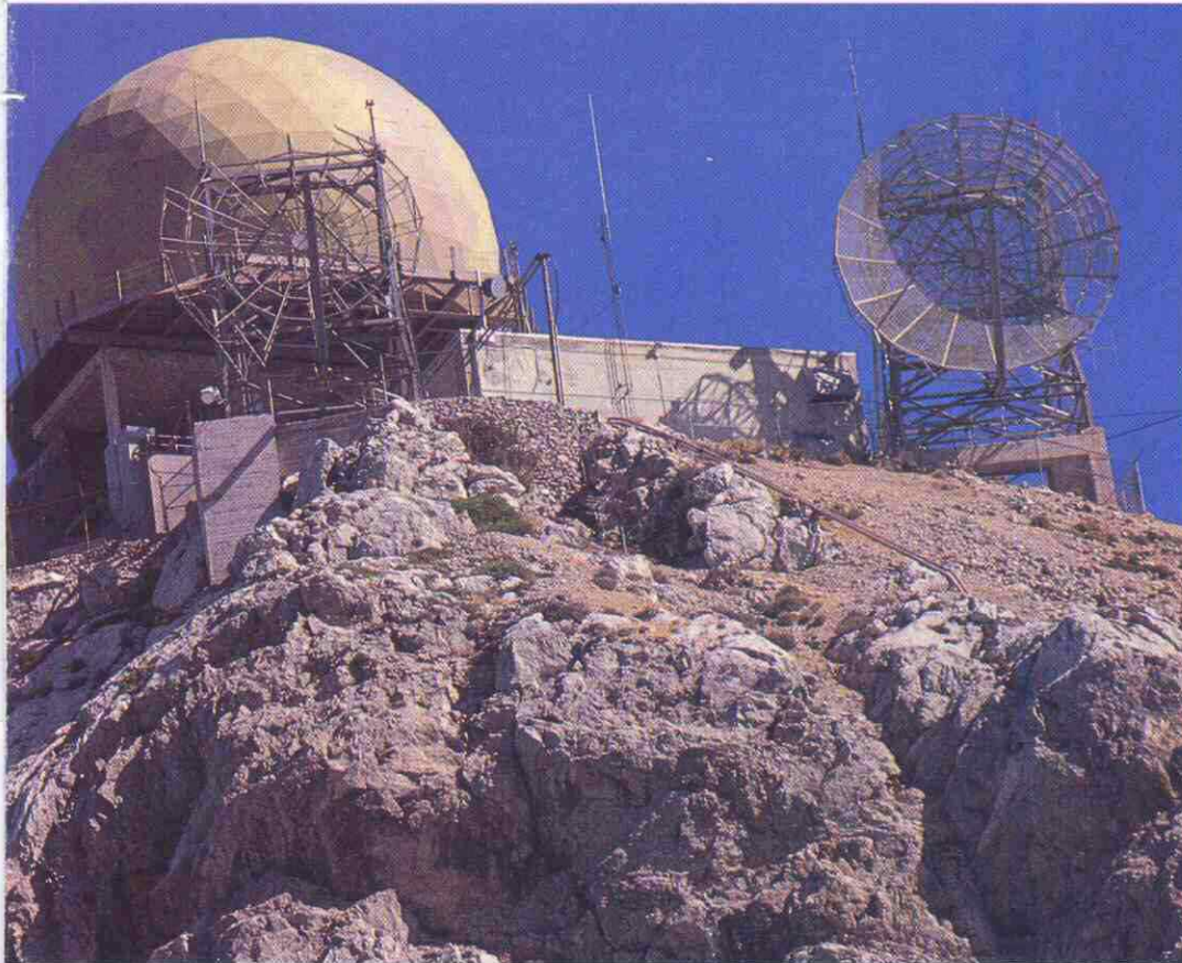
La Fuerza Aérea tienen la misión de proteger de las inclemencias meteorológicas a las antenas de los radares.
