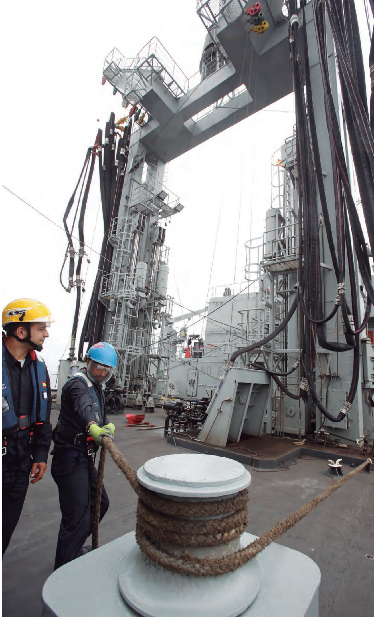
El Patiño en su base de Ferrol (izqda.). El buque dispone de dos pórticos, uno situado a proa (dcha.) y otro a popa, de los que cuelgan las mangueras de combustible. El flujo de transferencia se supervisa desde la Cámara de Control de Plataforma (arriba).
