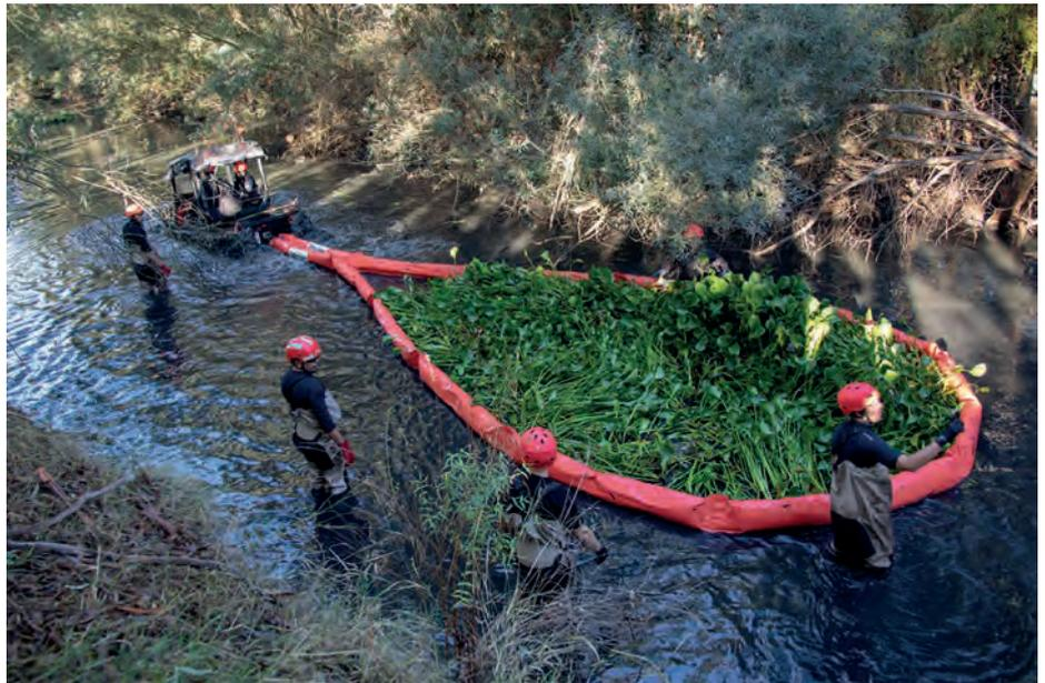
Las barreras de arrastre, específicamente diseñadas para la recogida del camalote, se utilizan para conducir la planta por el río hasta las zonas de extracción.
