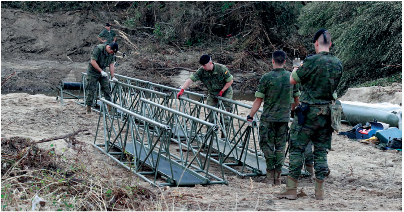
Militares del Batallón de Zapadores Paracaidistas instalan una pasarela peatonal para sustituir uno de los puentes destruidos por el agua en Aldea del Fresno.
