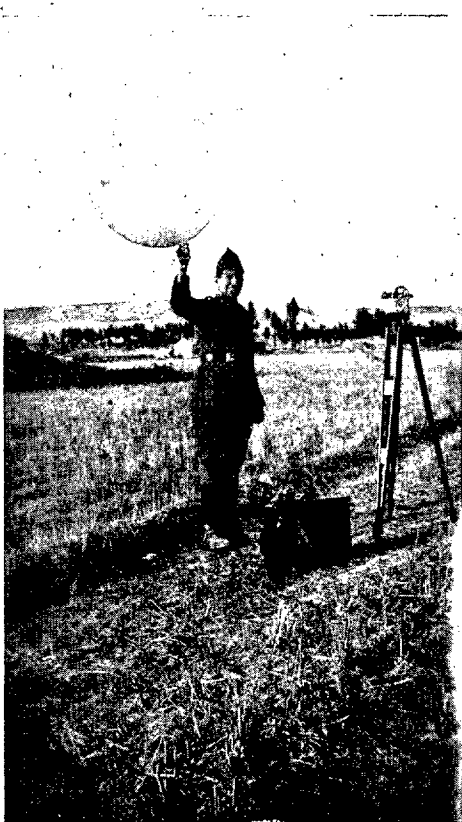
Teodolito y globo empleado en las secciones meteorológicas.
