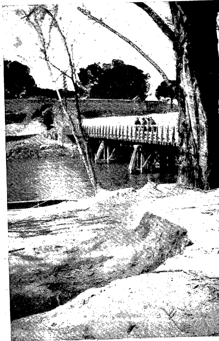
El puente de pilotes con el muro de sacos terreros, visto desde la Universitaria. Al fondo, la tapia de la Casa de Campo.
