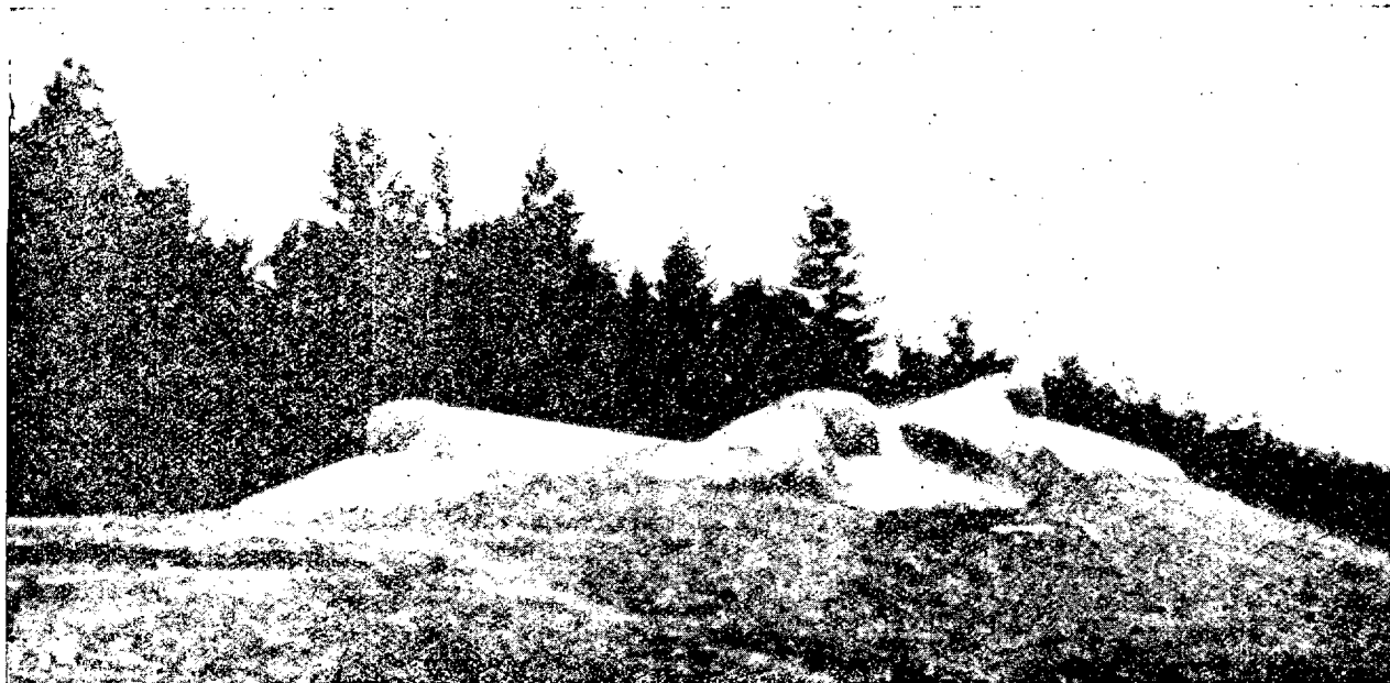
Obra con tres cúpulas acorazadas para Infantería.
