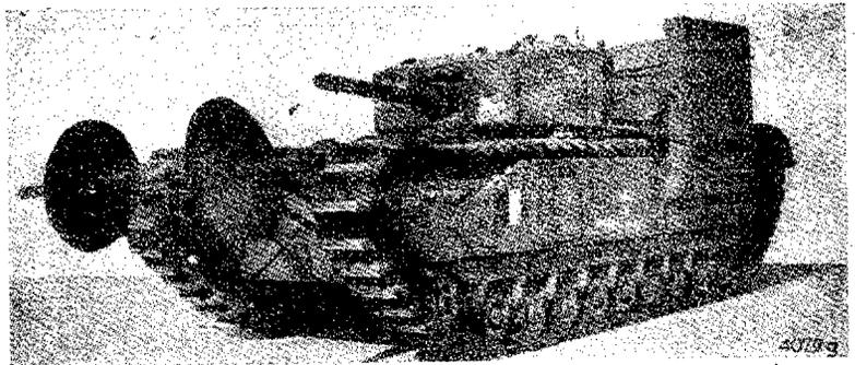
FIG. 25.—Tanque de Infantería inglés "Mark IV" (antes Churchill III). con chimenea de entrada y salida de aire, con objeto de aumentar su capacidad de vadeo durante el desembarco de Dieppe. En la parte delantera lleva adosado un soporte de cargas explosivas.
