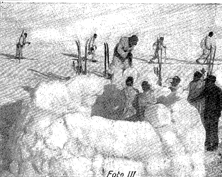
Foto núm. 1: Tallado de los bloques utilizando el zapapico de mango corto.—Foto núm. 2: Transporte de los bloques utilizando los esquís como vía.—Foto núm. 3: Construcción del iglú.
