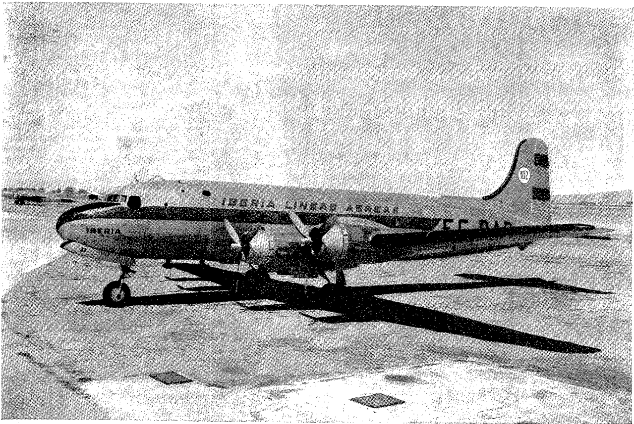
Nuevos aviones adquiridos por la Compañía Española "Iberia". Son de construcción metálica, en duraluminio, no sólo el fuselaje, planos, depósitos de esencia, timones..., etc., sino también los servicios interiores, como butacas de tubo metálico, portaequipajes, servicios de saneamiento..., etc.
