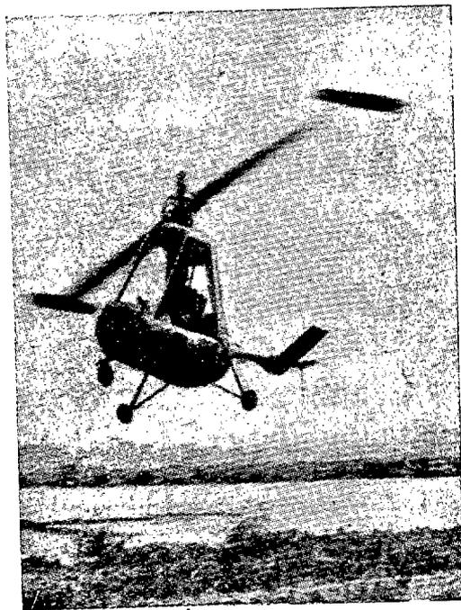
La propulsión de este nuevo helicóptero se basa en el principio de la pulsorreacción, análoga a la empleada en las bombas volantes alemanas V-1, mientras que los res-
