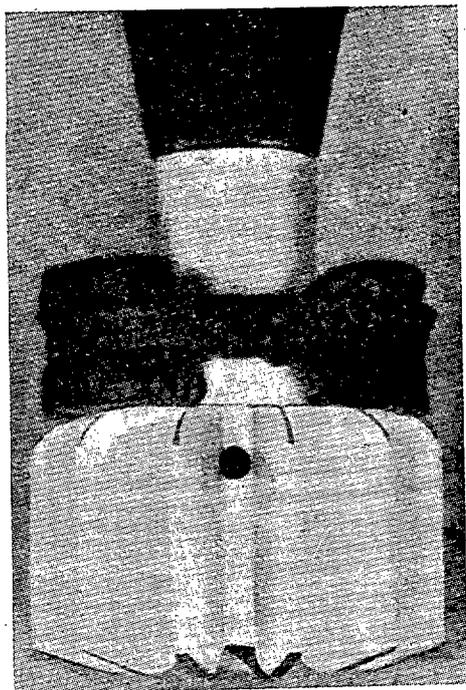
Fig. 5.ª—Cola estabilizadora de granada I. Z. A. R. de 81 mm. con suplemento en herradura.
