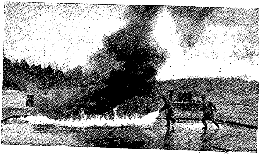
Fig. 3. a — Prueba de un agente extintor de incendio sobre gasolina de alto número de octano.
