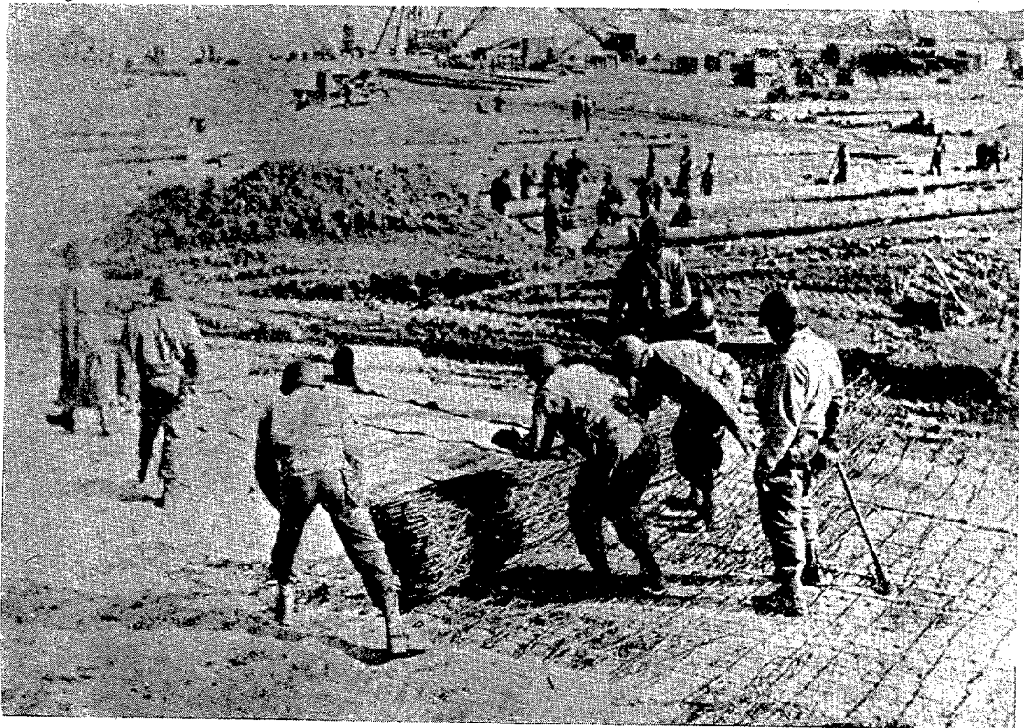
Construcción de una pista de aterrizaje de circunstancias.
