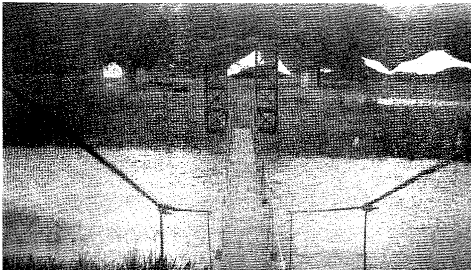
Vista de la pasadera desde uno de los caballetes de apoyo de los cables de suspensión.
