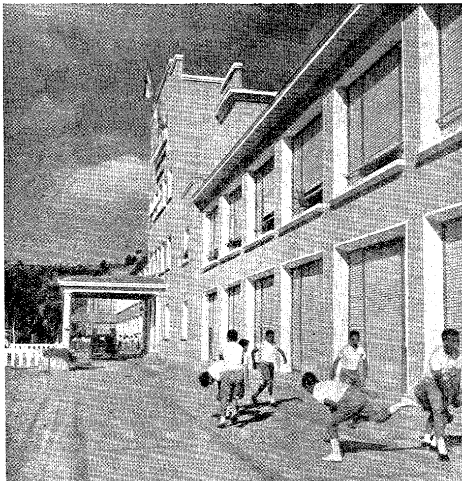
Colonia infantil "General Varela", en Quintana del Puente.
