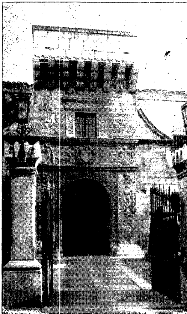
Barbacana y matacán de la entrada.
