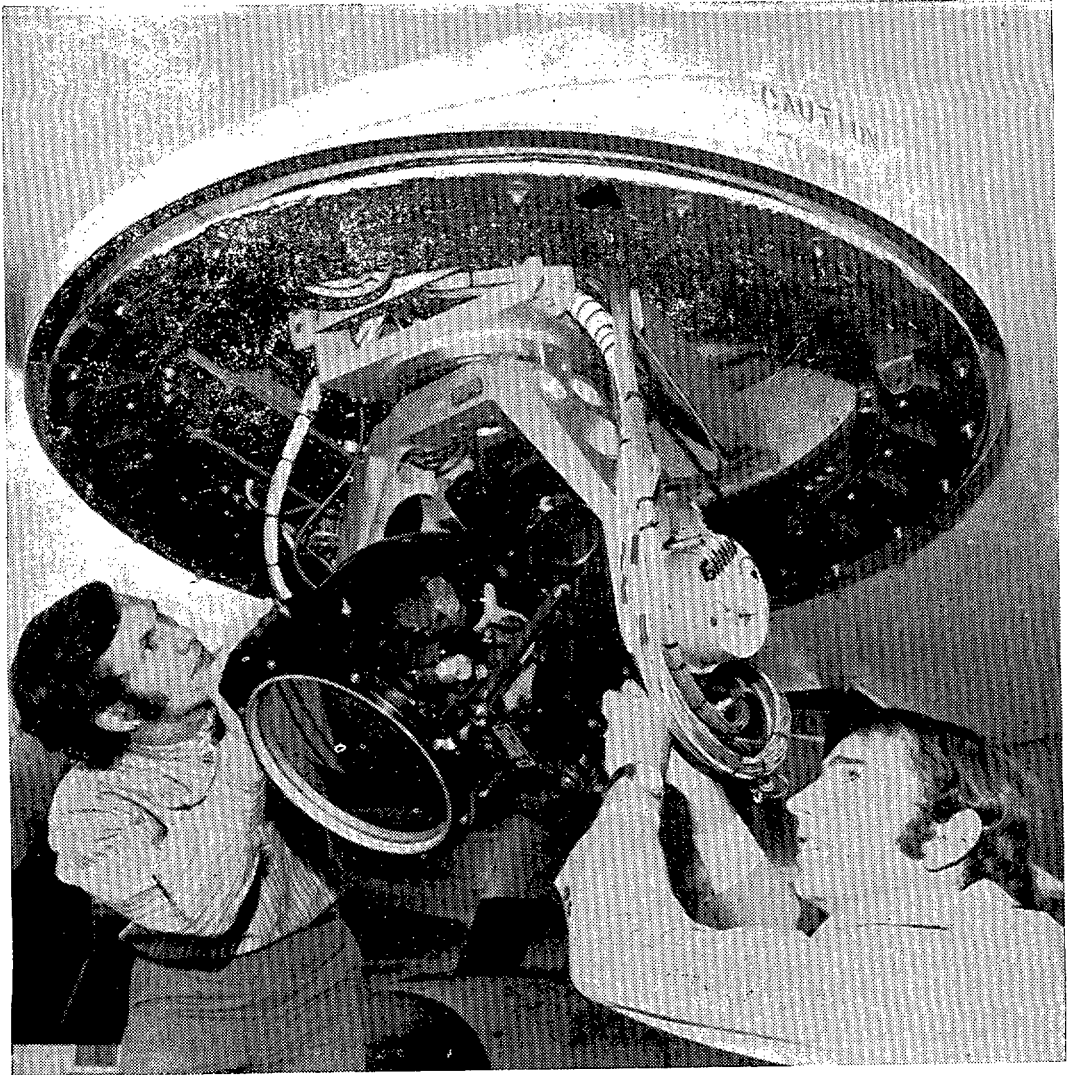
Momento de instalar el sistema infrarrojo NODLS en la torreta de un avión C-136.
