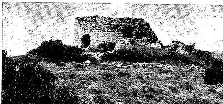
Foto núm. 1 bis.—Vista general de la Torre.
