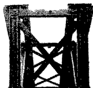
2 PONTS BAILEY TYPE D-D- DE 24.40 M. DE PORTÉE BON DE L'ESPAGNE A LA TUNISIE
