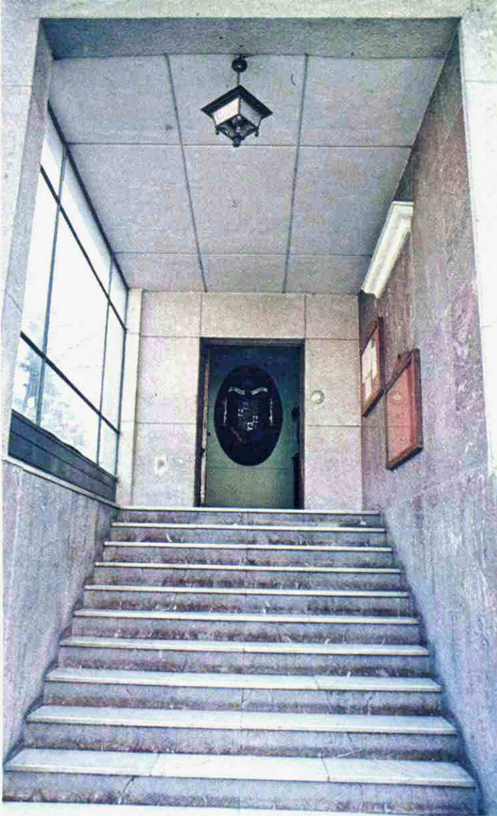
La escalera de acceso a las aulas.
