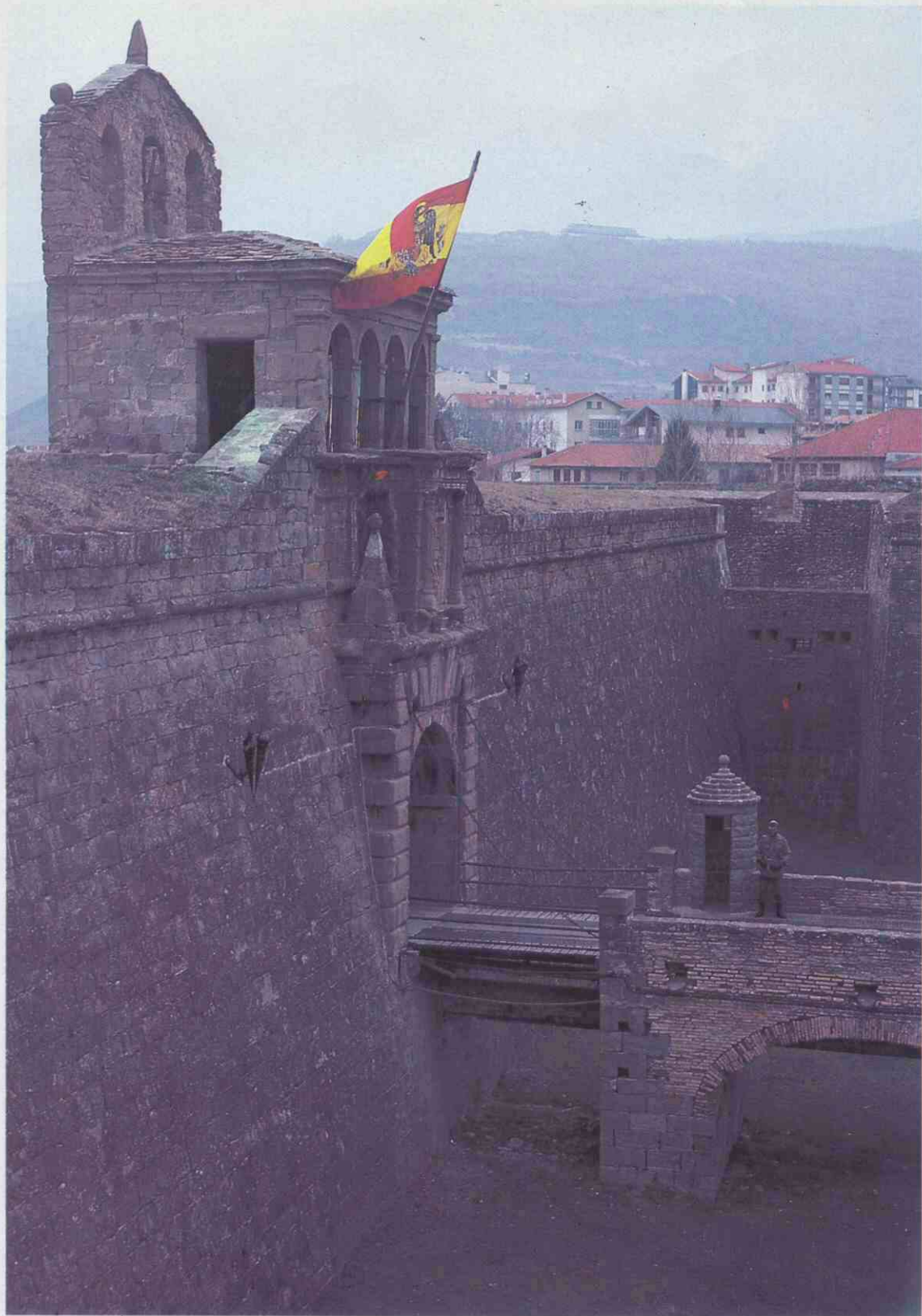
El puente fijo de la entrada termina en un tramo levadizo, que aislaba la entrada durante los ataques. El conjunto produce una impresionante sensación de solidez y fuerza.
