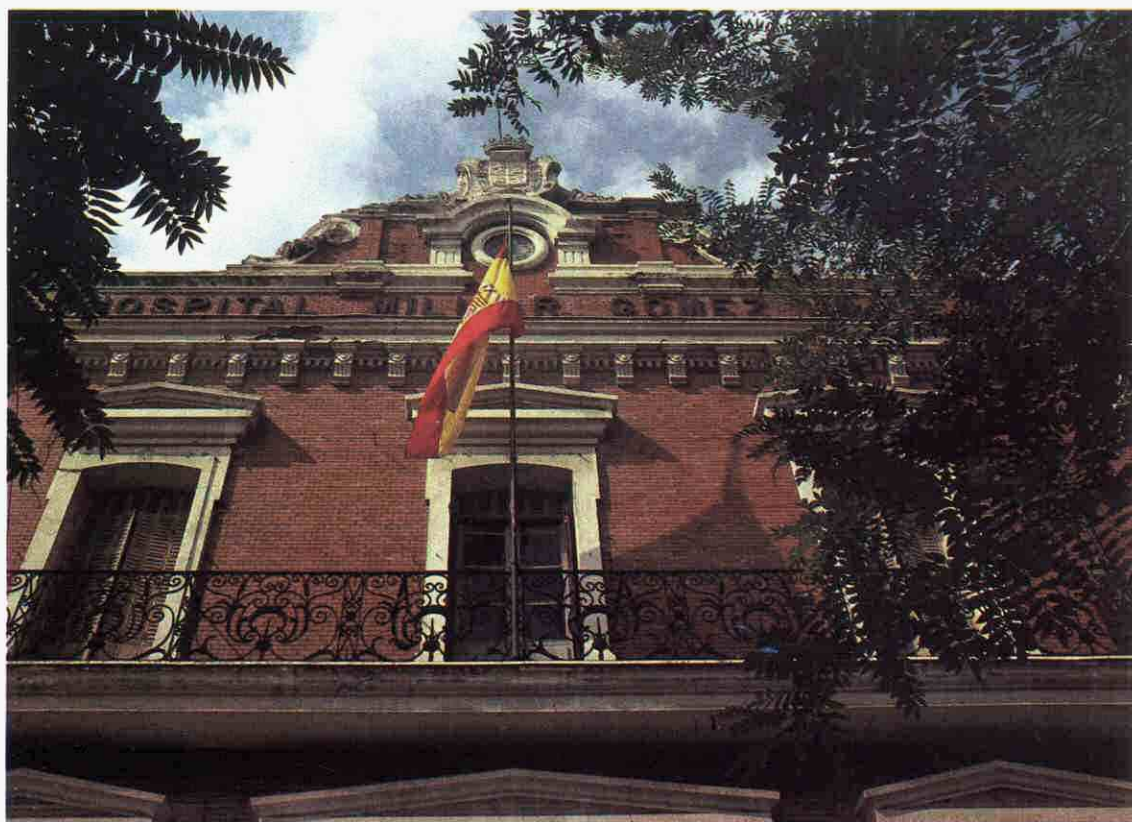
La fachada que da a la Glorieta del Ejército se conservará como recuerdo del primer Hospital Militar de Carabanchel, algunos de cuyos pabellones aún funcionan en espera del relevo. Desde 1946, el Hospital está dedicado al doctor don Mariano Gómez Ulla, extraordinario cirujano y una de las mayores glorias de la medicina militar española. (Foto J. F. Blanco)
