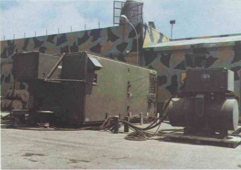
Central de operaciones AN/TSQ-73.
