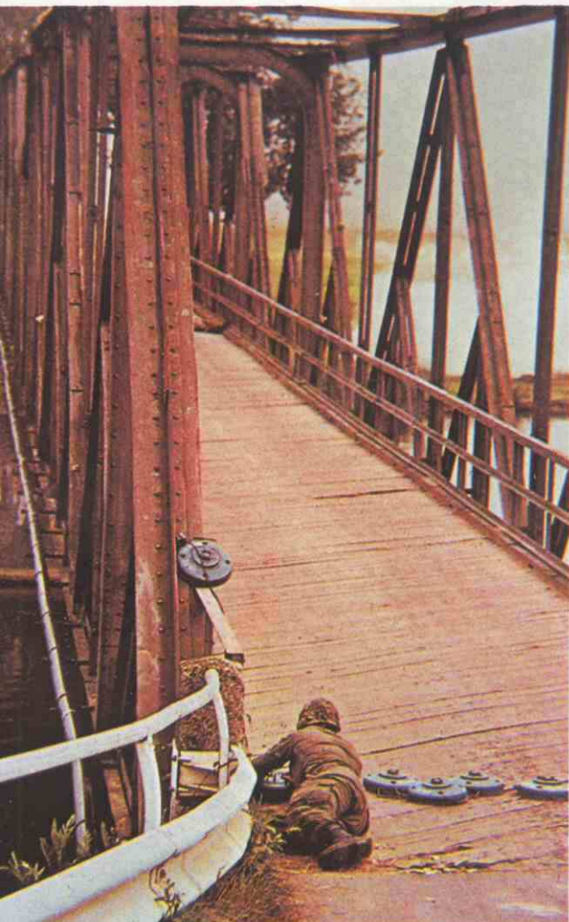
Zapadores. Ejercicio de colocación de cargas para voladura de un puente.
