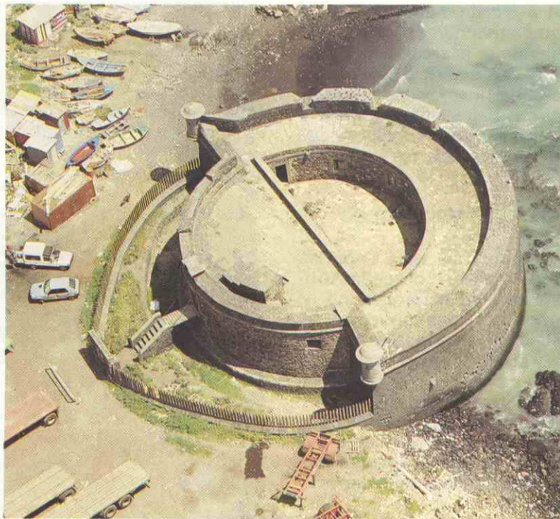
Vista aérea en la que se aprecia la particular tipología del castillo y lo degradado de su entorno actual.
