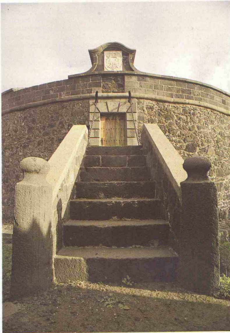
Escalera de acceso y puerta principal.
